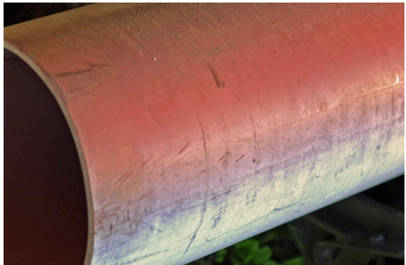
Verfärbung eines Rohres durch Einwirkung von Sonnenlicht über mehrere Jahre.
