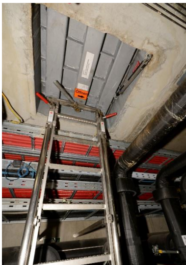
Der Deckel des ins Freie führenden Ausstiegs aus dem "engen Raum" muss gegen Zufallen gesichert sein. Außen muss eine Umwehrung mit Durchgangssperre einen Absturz bei geöffneter Luke verhindern!
