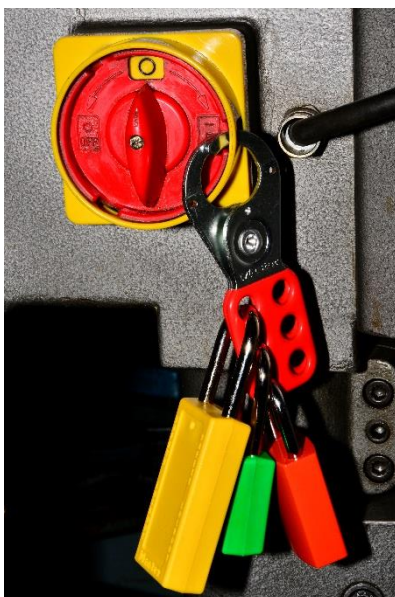
Schlüsselsystem mit "Zange" an einem einfachen Schalter.
