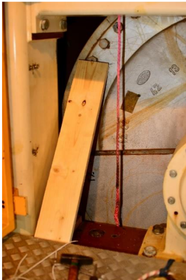
Improvisierte Verdrehsicherung an einem Trockenzyylinder einer Papiermaschine mittels Kantholz (ohne Schließsystem- Sicherung).
