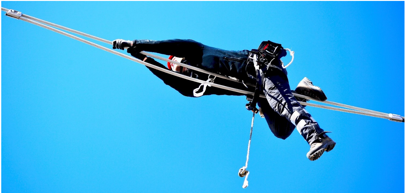
"Befahren" eines Leiterseils einer Hochspannungsleitung in ca. 40 m Höhe für Wartungs- und Reparaturzwecke.
